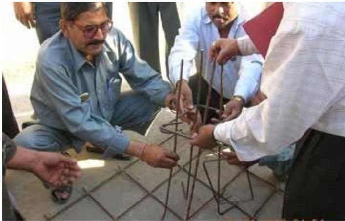
图 2：泥瓦匠们在建造抗震学校之前参加培训，包括动手操作建造自己的抗震模型。
